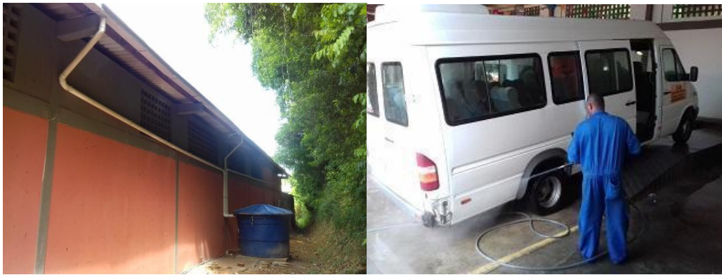
Figura 50: (a) Sistema de captação de águas de chuva; (b) Utilização da água captada.
