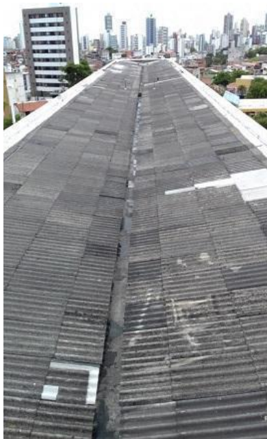
Figura 51: Vistoria técnica no telhado da Escola Politécnica campus da Federação. Fonte: Acervo CMA (2018)
