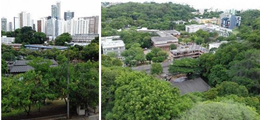
Figura 49: Vistas aéreas de áreas de cobertura de algumas edificações que conferem considerável potencial para a instalação de reservatórios de captação de água de chuva na UFBA. (a) Vista geral do campus Ondina. (b) Vista geral dos prédios que estão localizados na Av. Reitor Miguel Calmon no campus Vale do Canela .
