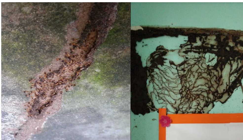
Figura 20: Presença de pragas urbanas nas unidades da UFBA. À esquerda, carreiro ativo de cupins e à direita, colônia de cupim instalada atrás de uma lousa na Creche. Fonte: Acervo CMA (2021).
